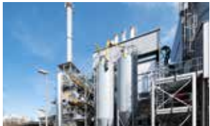
UNITÉ DE VALORISATION ÉNERGÉTIQUE FENIIX
