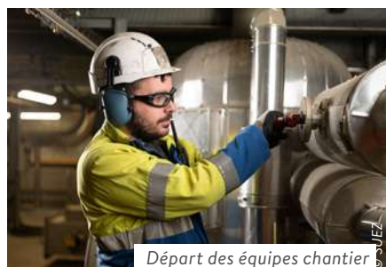
Départ des équipes chantier
